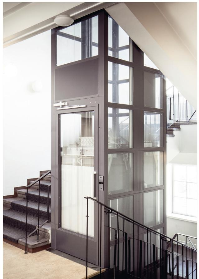
El hueco del ascensor KONE ProSpace es autoportante, por lo que no genera esfuerzo en el edificio.
